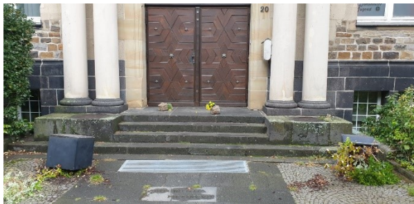
Vandalismus vor dem Hauptportal
