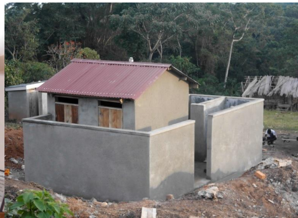
Toilettenneubau am Kinderheim
